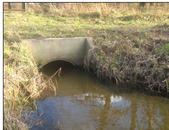
Rys. Przykład zamulenia przepustu. Ciek Ada. Zdjęcie wykonano 18.11.2017 r.
