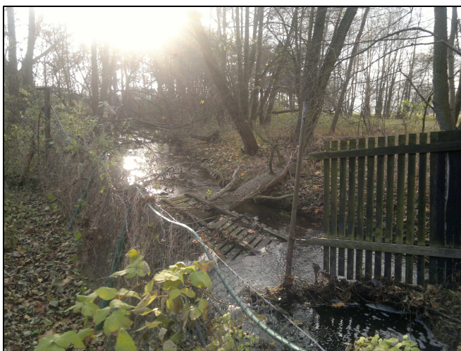
Rys. Przykład niedrożności koryta. Ciek Ada. Zdjęcie wykonano 18.11.2017 r.
